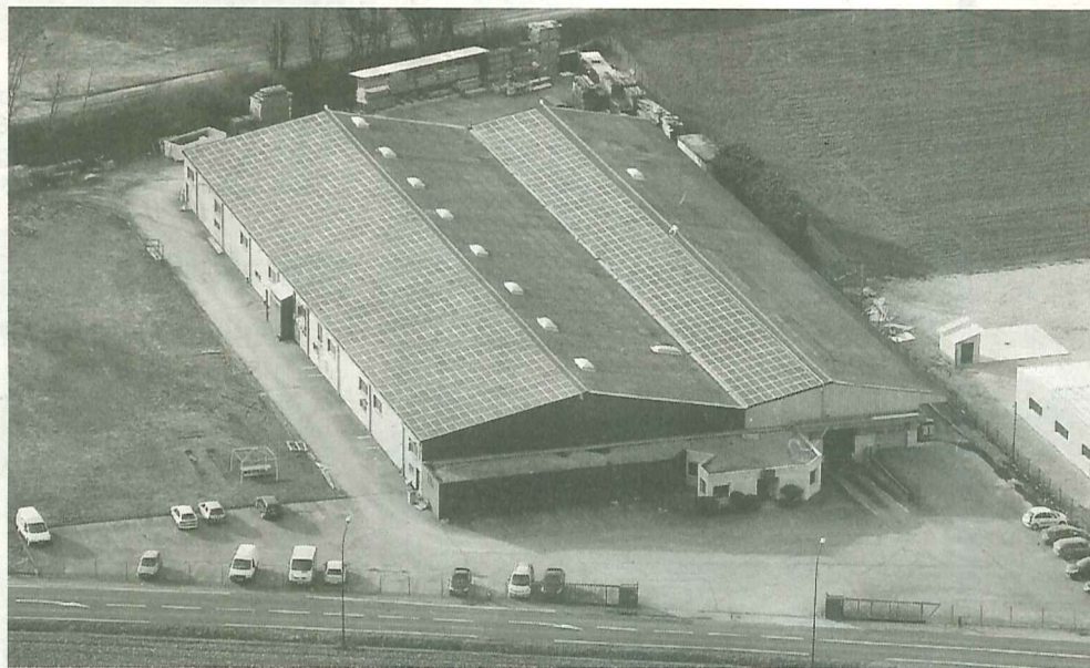
La centrale photovoltaïque sur le toit de l'usine de Cordon.
